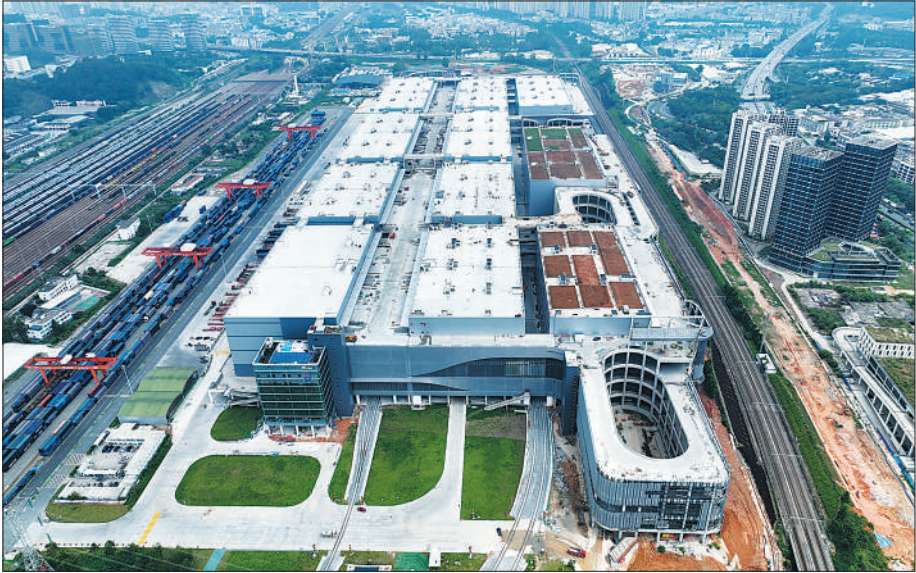
深圳平湖南综合物流枢纽项目全景。
